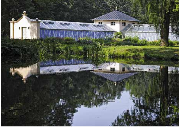
222 Branitz, historische Gewächshäuser (von links nach rechts): »Blaues Haus«, Kuppelhaus (Heizhaus) und Ananashaus, 2014 (Foto Hans Bach)
